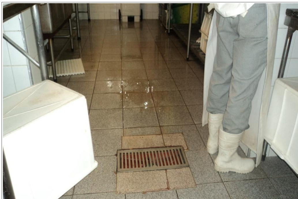
Figura 4.1 – Dificuldade de escoamento da água no piso.
